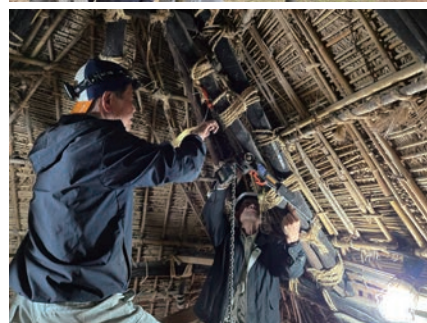
折損箇所修理状況
