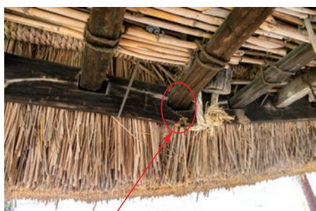
折損箇所および折損状況
